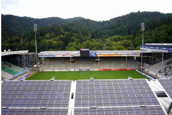
Thiết kế sân vận động có mái che ở Bauban với hệ thống pin mặt trời trên phần mái
